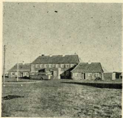
Nuværende stationsbygning i Hirtshals er imponant
