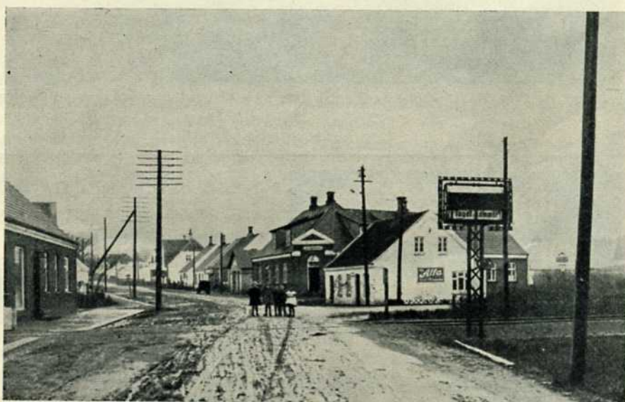
Overskæringen i Tårs 1926. T. h. advarselsskilt, der normalt var dækket af en plade, der ved kædetræk hejstes op for: Toget kommer.
