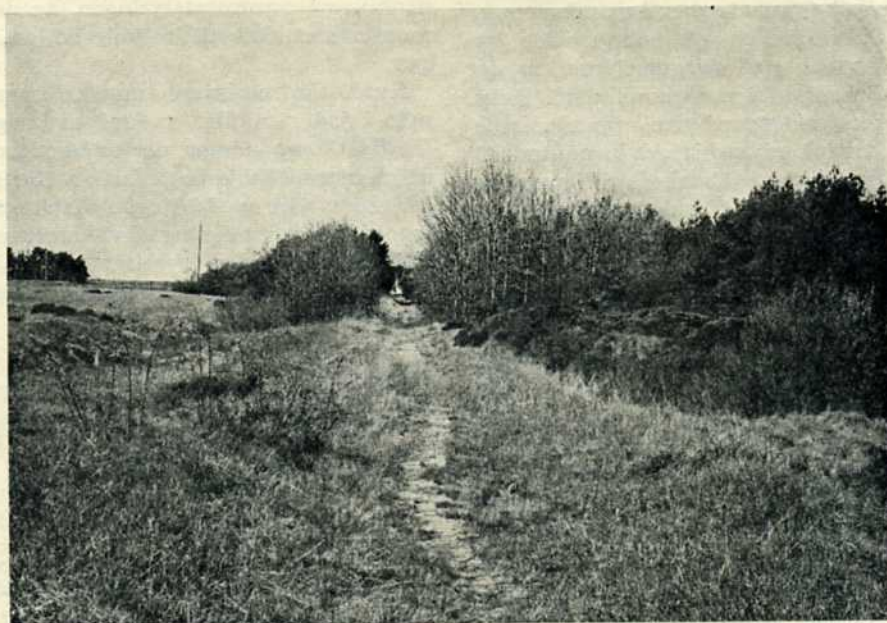
Kragsskovhede – 600 mm baneforløb mod v.-nv., vel 100 m vest for remisen. Foto: SAG.
